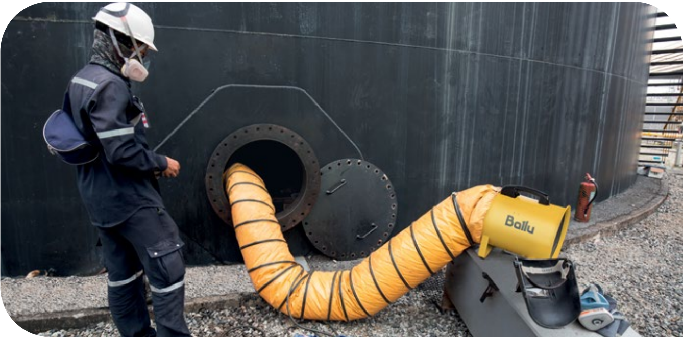
Приток и вытяжка в замкнутых пространствах
