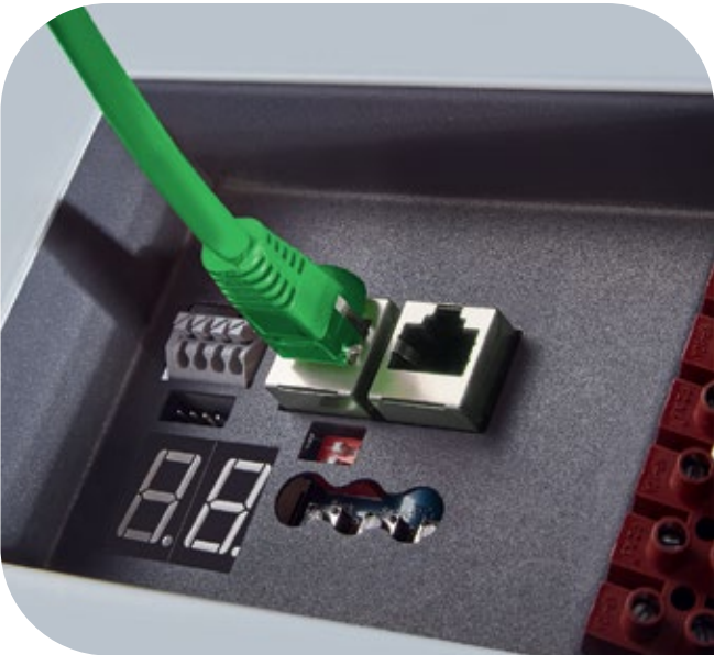
Подключение к системе BMS по протоколу Modbus
