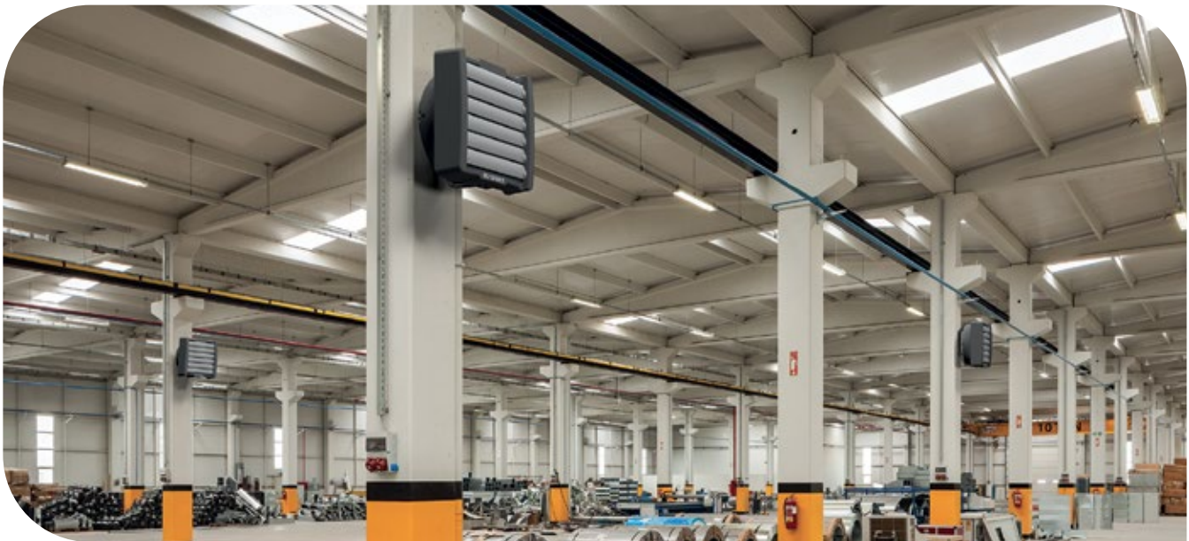
Промышленный тепловентилятор в компактном корпусе
