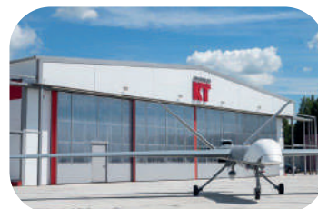
Завод Кронштадт, г. Москва
