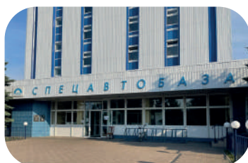
ГУП Водоканал, г. Санкт-Петербург
